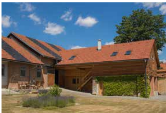
Nedávno dokončené stylové ubytování.
